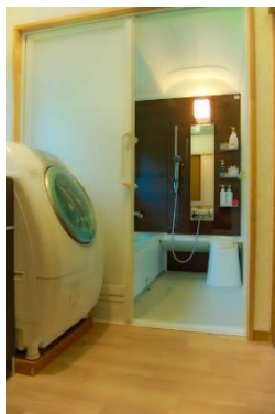
↑浴室の 片引き戸 、2cm近くあった床段差も解消され、浴室～洗濯・洗面室～トイレまでバリアフリーになりました。
