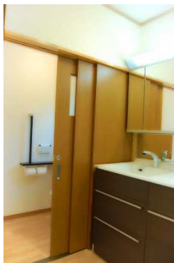
↑トイレの 2枚連動引き戸 。連動引き戸は限られた寸法の中で片引き戸より広い開口スペースを確保できます。
