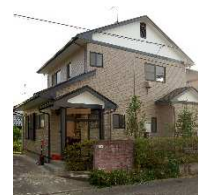
家まるごと耐震工事 4,060,000 円
