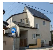
屋根・外壁塗装 1,210,000 円
