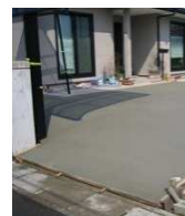
駐車場土間コン 420,000 円
