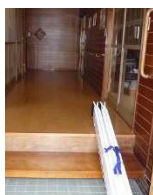
廊下床段差解消 380,000 円
