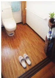
床段差を解消し、 ドアは引き戸に交換
