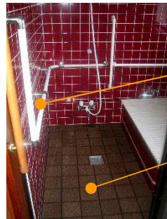
床段差を解消し、 ドアは引き戸に交換
