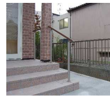
玄関アプローチの 手すり・スロープ工事
