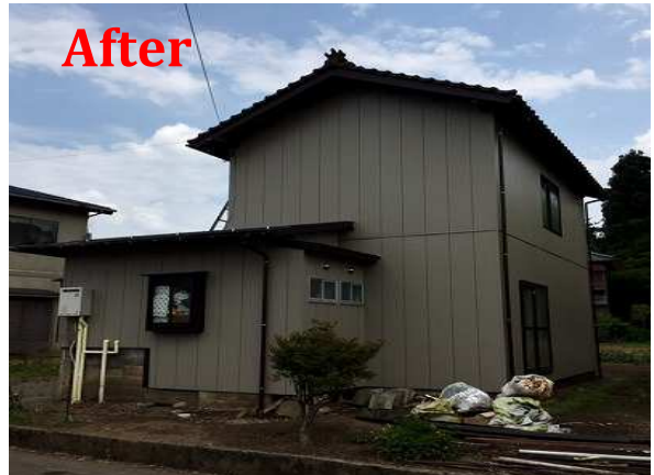
IGサイディング張替工事 木製窓⇒アルミサッシ交換 一階屋根葺き替え 破風板金巻 雨樋交換
