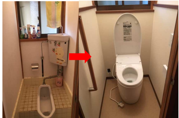
和式⇒洋式(TOTOネオレスト) 壁クロス・床CF・手摺・電気工事 工期2日
