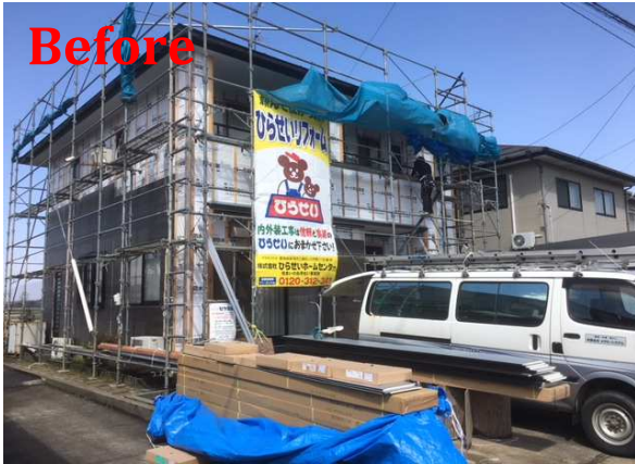
IGサイディング重ね張り 破風・軒天・屋根塗装 雨樋交換
