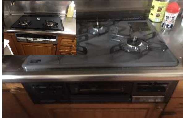
ガラストップビルトインコンロ交換 ホーロートップ75cmから60cmタイプへ取替え * 60cmから75cmへの変更も可能
