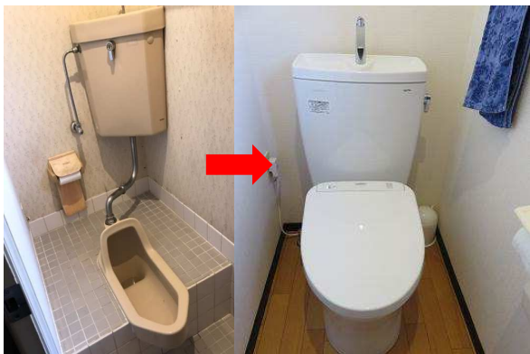
和式⇒洋式(TOTOKQ+オート洗浄) 壁クロス・床CF・手摺・電気工事 工事2日
