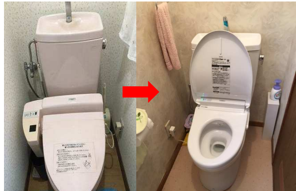
TOTO KQ便器+オート開閉+オート洗浄 工期1.5日
