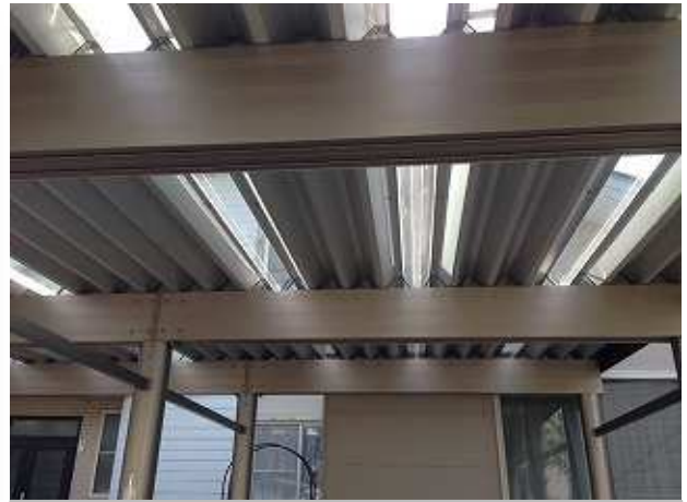
明り取り屋根取付
