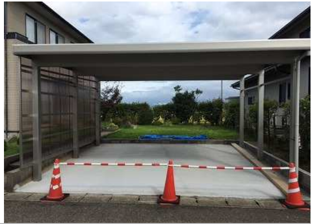
土間コンクリート作成+カーポート設置+サイドパネル
