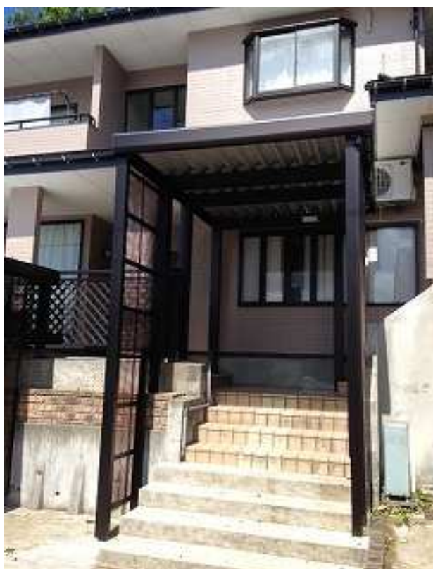
玄関前のアプローチ屋根として
