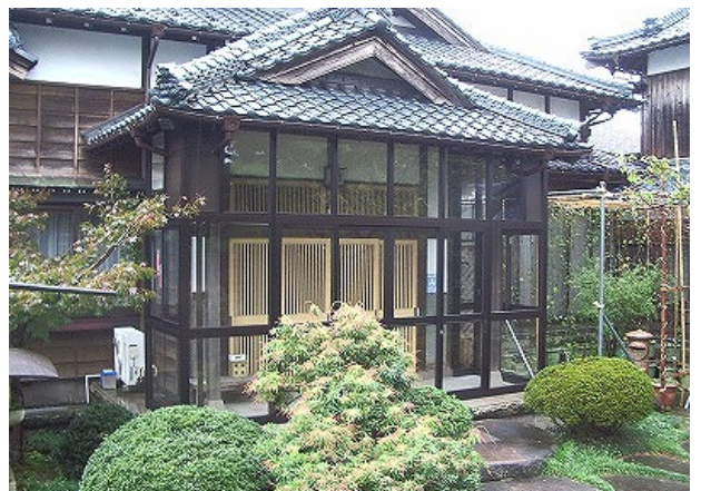
玄関風除囲い(伝統和風)
