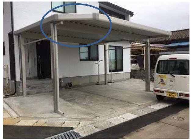
出隅斜めカット
