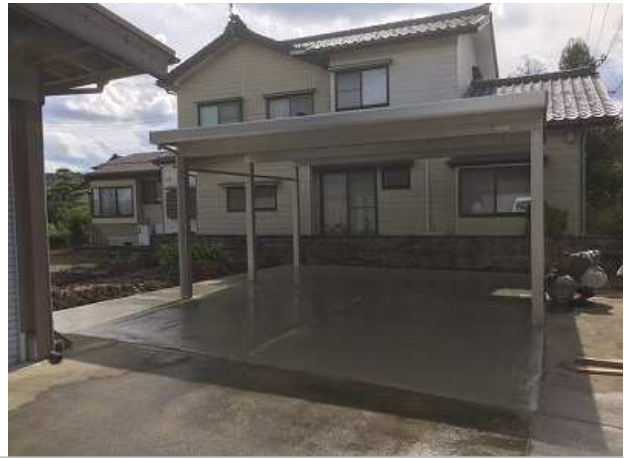
土間コンクリート作成+カーポート設置
