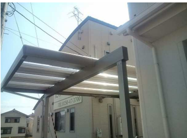
桁張り出し施工
