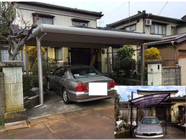
既存カーポート建て替え
