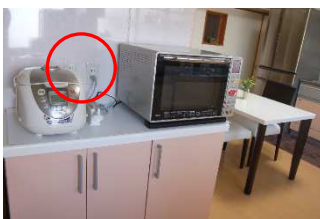
↑家電専用回路のコンセントを取付けました
