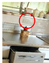
↑カウンター上にコンセント増設
