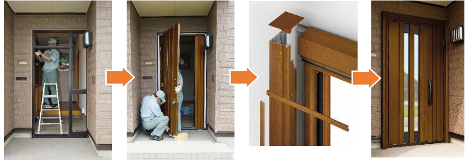
古いドアの取り外し 新しいドア枠とドアの取付 カバー工法 なので一日で完成
