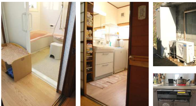
浴室・洗面室改装工事、エコキュート&IH 設置
