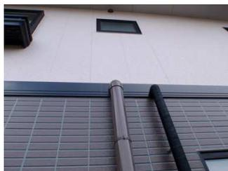
外壁材のつなぎ目や窓回りのシーリング補修や錆びた配管支持金具交換を行ってから耐久性のある塗料で外壁及び軒天を全面仕上げました。 工事費:887,000円(M様邸)
