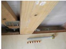
↑ケミカルアンカーによる基礎と土台の緊結、筋交い補強金具取付
