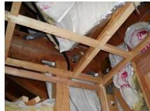
↑天井をはがし柱と桁、筋交いの金具による補強
