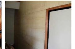
↑全ての壁の石膏ボードをはがし構造用合板に張替えて補強
