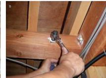
↑ボルトの締め直しや階段室のクギ増し打ち補強
