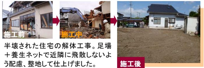
半壊された住宅の解体工事。足場+養生ネットで近隣に飛散しないよう配慮、整地して仕上げました。
