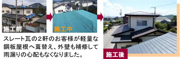
スレート瓦の2軒のお客様が軽量な鋼板屋根へ葺替え、外壁も補修して雨漏りの心配もなくなりました。
