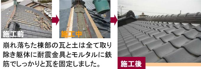
崩れ落ちた棟部の瓦と土は全て取り除き躯体に耐震金具とモルタルに鉄筋でしっかりと瓦を固定しました。
