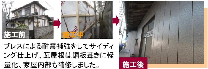
プレスによる耐震補強をしてサイディング仕上げ、瓦屋根は鋼板葺きに軽量化、家屋内部も補修しました。
